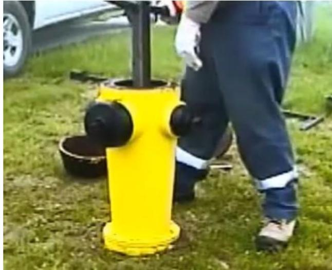
14. Sortez maintenant le mécanisme intérieur
