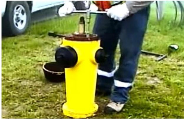
10. Dévissez maintenant l'écrou de manœuvre
